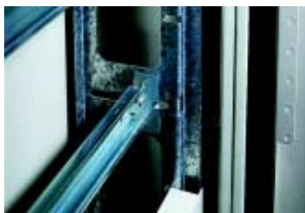
Регулирование установки по глубине симметричной DIN-рейки
